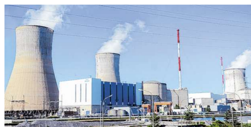
Das Kraftwerk von Tihange: Nach Aussage von Engie-Electrabel ist es kein Problem, dort noch Jahrzehnte Strom zu produzieren.
